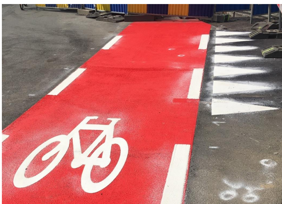
Figure 1.9 : réfection d’une piste cyclable suite à la pose d’un câble
