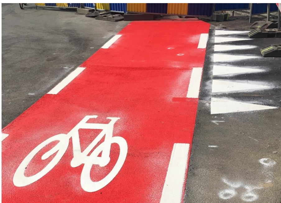
Figure 1.9 : piste cyclable aménagée suite à la pose d’un câble
