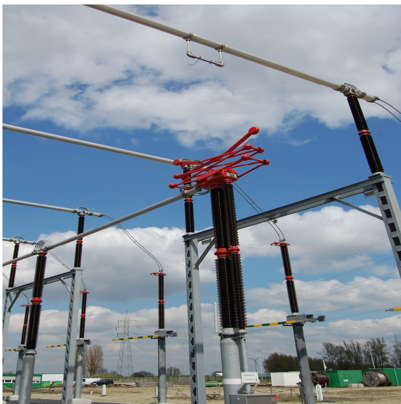
Photo 9-4: sectionneur d'aiguillage de type pantographe avec sectionneurs de terre (vert-jaune) à l'arrière-plan.
