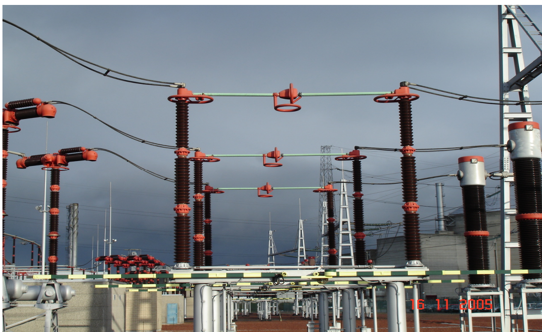
Photo 9-5: sectionneurs de lignes de type horizontal et rotatif (en position fermée)
