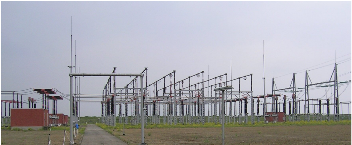
Photo 9-2: travées 380 kV isolées à l'air (AIS)
